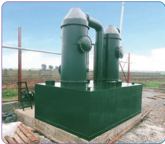
💧 Cung cấp và lắp đặt hệ thống khử mùi cho dự án xử lý nước thải thành phố Ninh Bình
