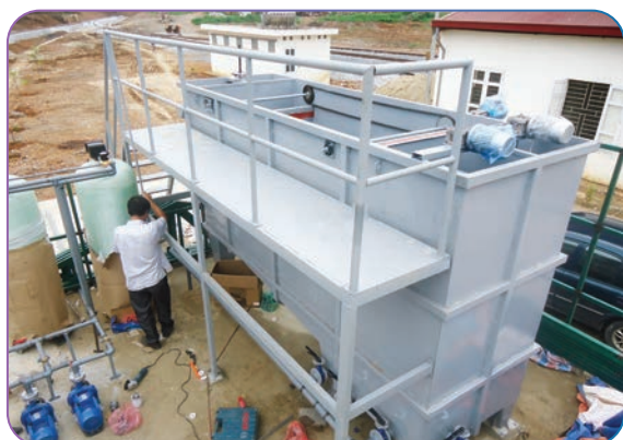
Nhà máy nước thải Ga Lào Cai
