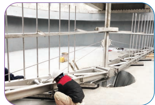
Nhà máy xử lý nước thải Lạng Sơn
