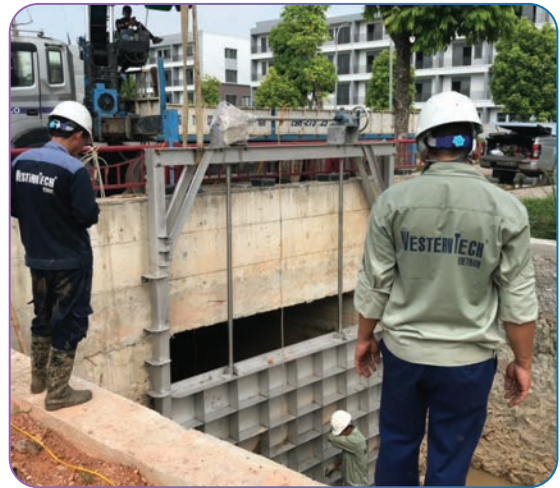
Nhà máy xử lý nước thải Hưng Yên
