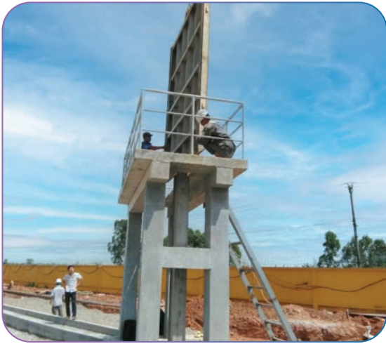
Nhà máy xử lý nước mặt Bắc Thăng Long
