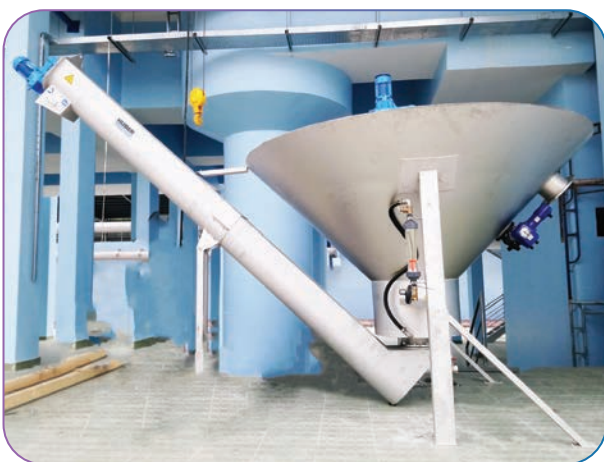
Dự án Nhà máy xử lý nước thải
