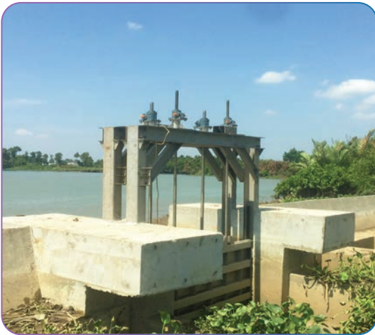
Dự án xử lý nước thải Ninh Bình
