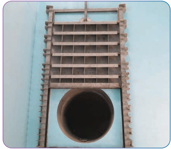
Nhà máy xử lý nước sạch Dĩ An
