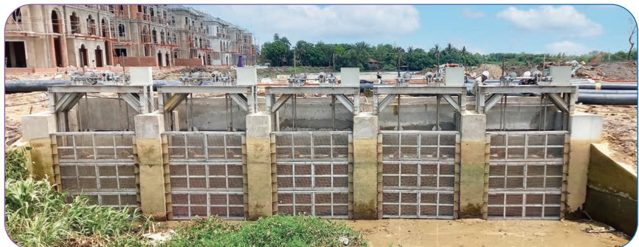
Nhà máy xử lý nước thải Ninh Bình
