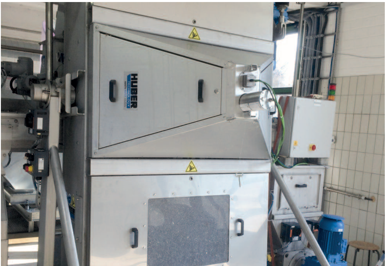
Hình 1: Hệ thống giám sát an toàn HUBER cài đặt trên Máy tách rác đa cào HUBER RakeMax®
